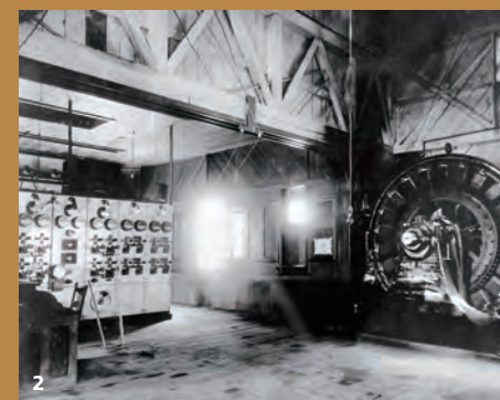
1 에디슨은 영화에도 관심이 많았다. 핸들을 돌려 동영상을 볼 수 있는 키네토스코프(Kinetoscope)는 1891년 발명품이다. 2 테슬라가 설계하고 제작한 세계 최초의 교류 발전기. 웨스팅하우스의 발전소에 설치됐다.
